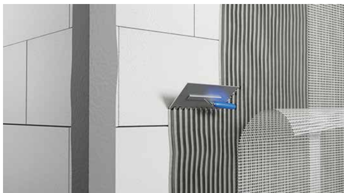
RYS.63 Poprawne nałożenie zaprawy klejowej
