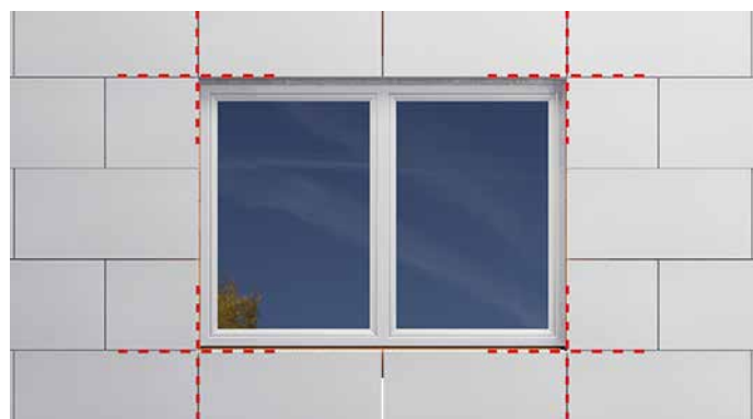
RYS.16 Błędne rozmieszczenie płyt styropianu
