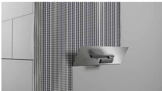
RYS.64 Zatopienie siatki w kleju na „zakład”
