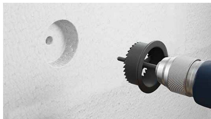
RYS.37 Frezowanie otworu w przyklejonym styropianie
