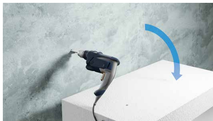
RYS.42 Nacechowanie płyty nowego ocieplenia
