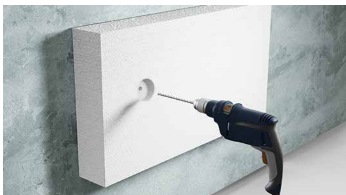
RYS.38 Wiercenie otworu pod łącznik Renovadex
