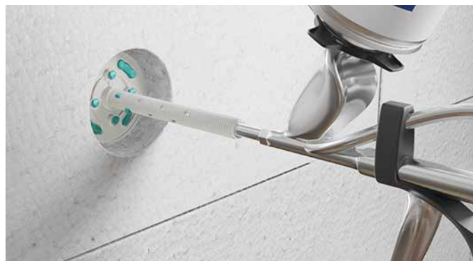
RYS.45 Iniekcja kleju poliuretanowego pod układ
