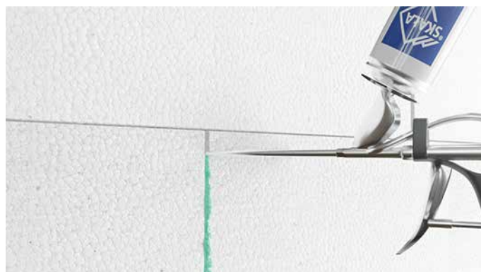
RYS.13 Wypełnianie szczelin klejem poliuretanowym
