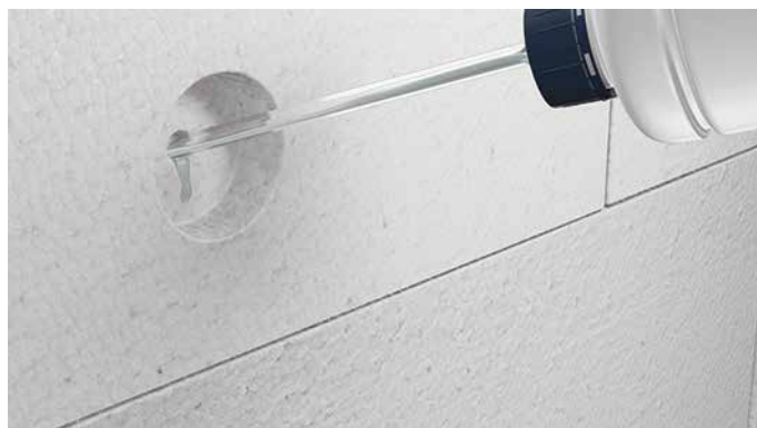
RYS.23 Gruntowanie nawierconego otworu
