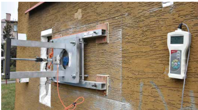
RYS.33 Pomiar wytrzymałości zakotwienia łącznika
