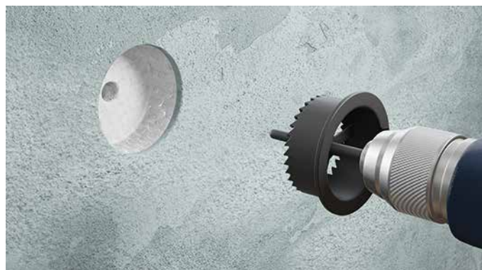
RYS.46 Wiercenie i frezowanie w naprawianej warstwie
