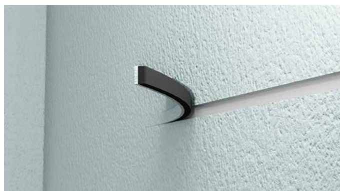
RYS.62 Montaż listwy odcinającej
