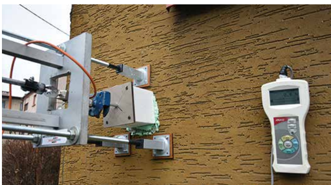
RYS.35 Pomiar przyczepności warstwy tynku
